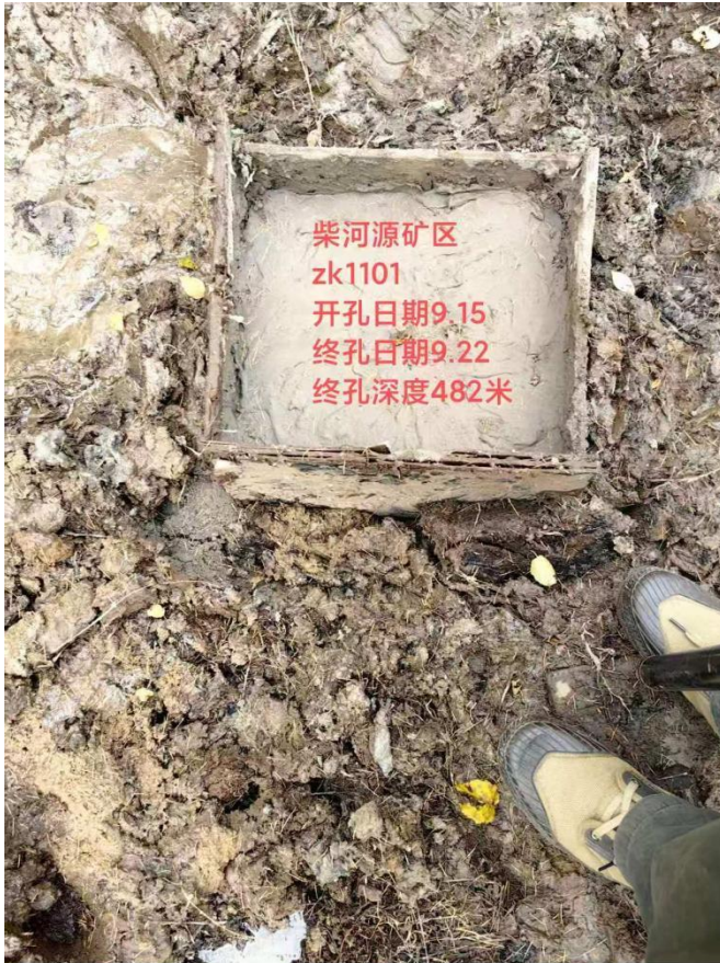
图 3-2 勘查后现地工程状况 (2)
