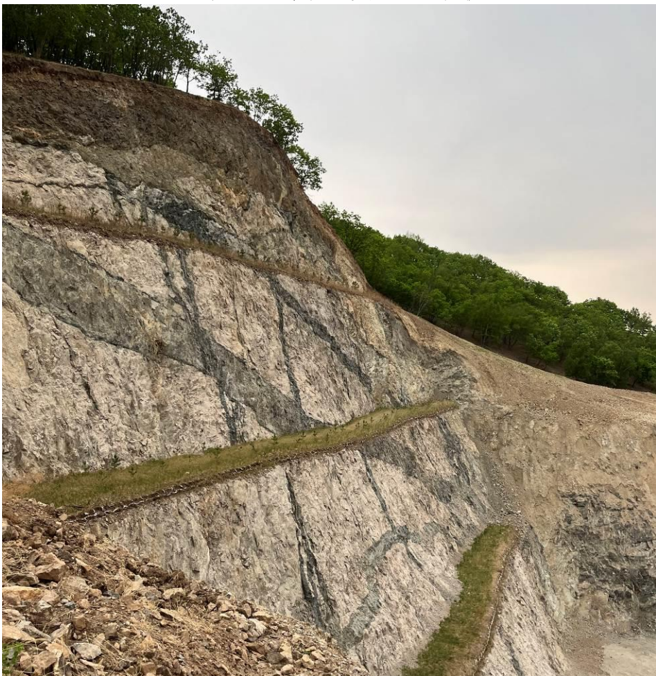
照片2-5 露天采场已复垦土地现状
